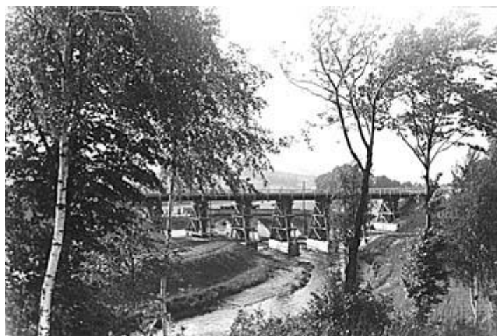
Dřevěný železniční most přes Metuji
