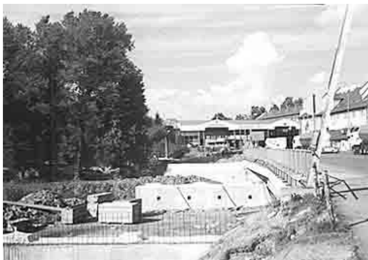
Rozestavěná část nové přístavby mostu
