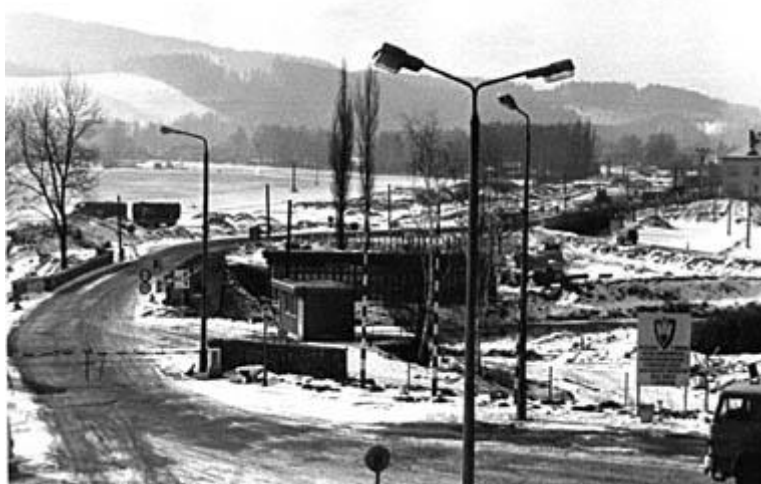
Rozestavěný nový betonový most
