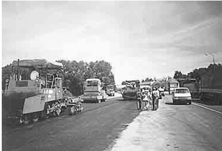
Stavební ruch na mostě za provozu
