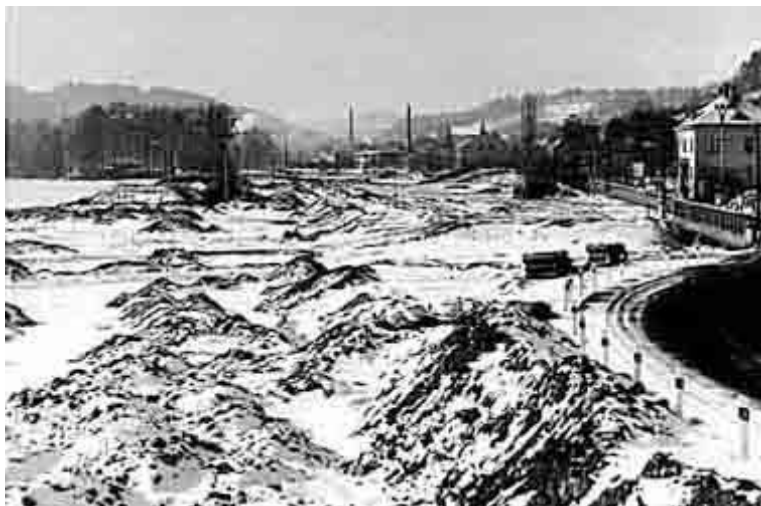
Příprava terénu pro stavbu Polské ulice
