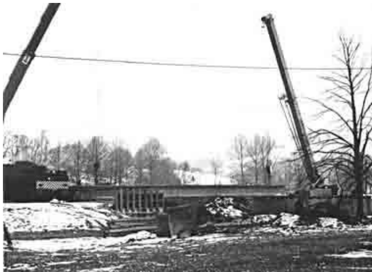
Stavba nového betonového mostu přes Metuji
