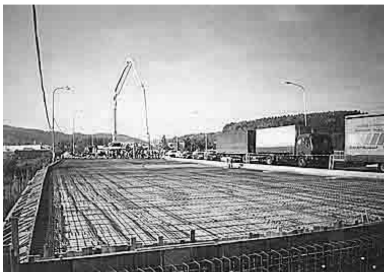
Nová mostní armatura
