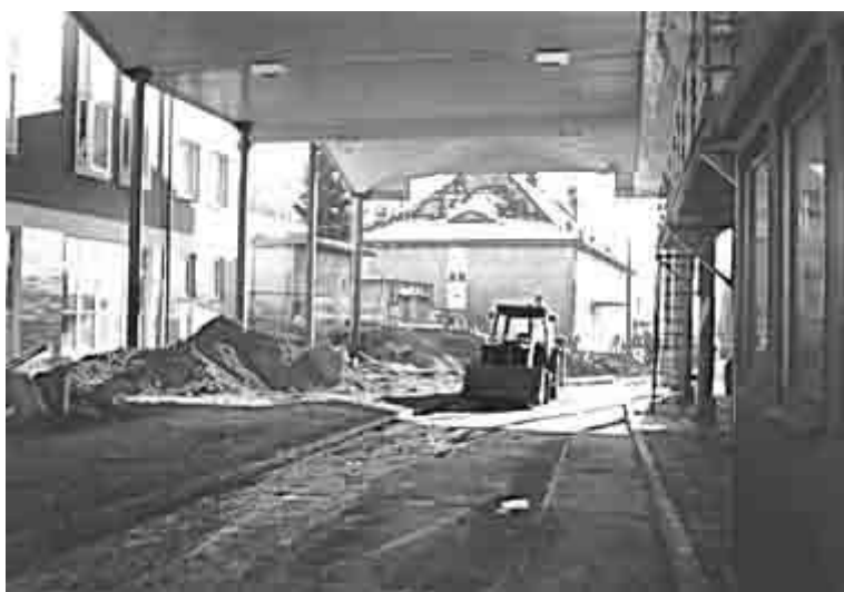
Další stavební práce probíhaly za provozu
