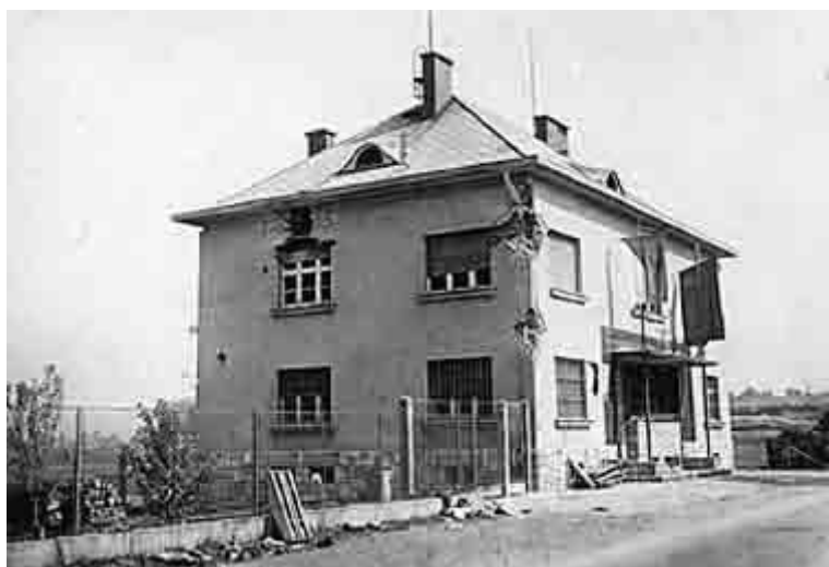
Budova nové české celnice (snímek až z roku 1945)
