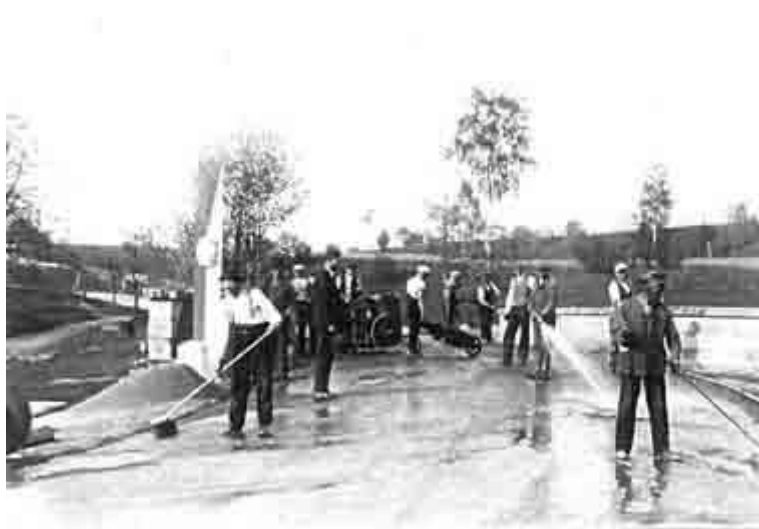
Asfaltování na Slánském mostě
